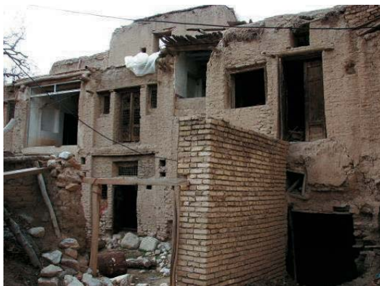
تصویر ۹ و ۱۰: استفاده از منابع طبیعی مانند سنگ، چوب و خاک در ساختار معماری روستاهای بومی که نقش به‌سزایی در کاهش هزینه ساخت و ساز دارد. راست: روستای نیچکوه نوشهر، مازندران - چپ: روستای بنافت مهریز، یزد (مأخذ: نگارندگان، ۱۳۸۶).
