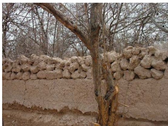
تصویر ۳ و ۴: سمت راست: استفاده از خاک و چوب‌های زائد درختان باغ‌ها در ساخت دیوار چینه ای - سمت چپ: الگوی رایج و ساده فضای ایوان در مسکن بومی روستاهای یزد. (مأخذ: نگارندگان، ۱۳۸۷)
