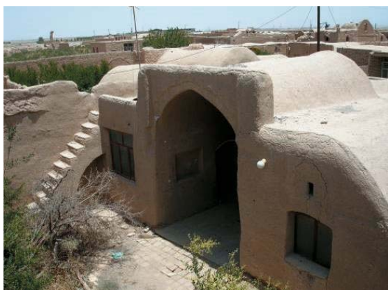
تصویر ۳ و ۴: سمت راست: استفاده از خاک و چوب‌های زائد درختان باغ‌ها در ساخت دیوار چینه ای - سمت چپ: الگوی رایج و ساده فضای ایوان در مسکن بومی روستاهای یزد. (مأخذ: نگارندگان، ۱۳۸۷)
