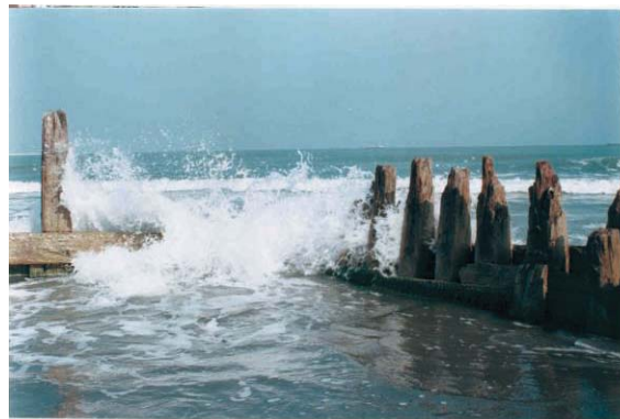
تصویر شماره ۱۸: تخریب شدید کشتی نکا بوسیله امواج دریا (تصویر از سورتیچی)
