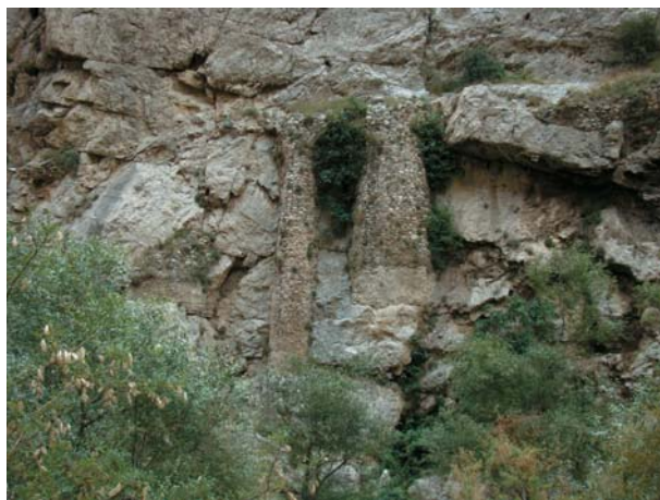
تصویر ۴. پایه های پل پشت تونل و آن به شکل نیم استوانه ای (عکس از نگارندگان)
