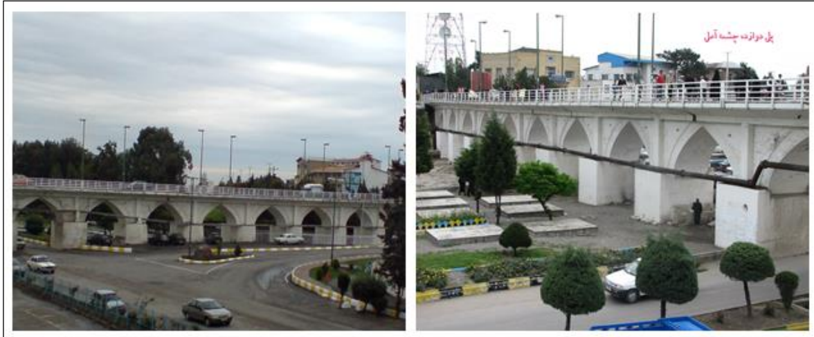
تصویر ۷. پل دوازده چشمه
