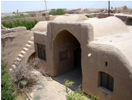
تصویر ۳. استفاده از خاک و چوب‌های زائد درختان باغ‌ها در ساخت دیوار چینه‌ای
