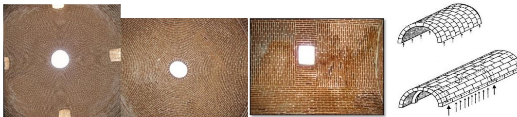
تصویر ۴ تا ۶ ترسیم ۶. طاق کلمبو گرمخانه- طاق عرقچین- طاق آهنگ (نگهداری لنگ)- باربری طاق آهنگ ماخذ: نگارنده - جزوه سازه دکتر تهرانی
